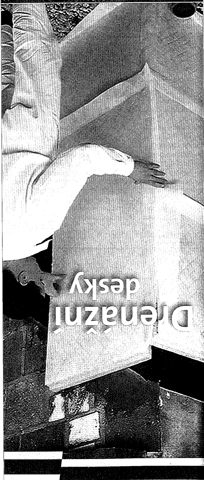
Příklad typického použití speciálních desek v oblasti přechodu soklu na suterén
